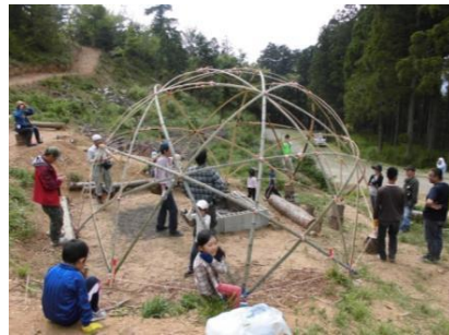
ここに竹ドームを設置しました
